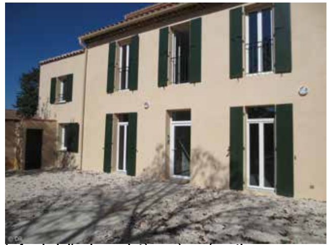
La façade de l'ancien presbytère après sa rénovation
