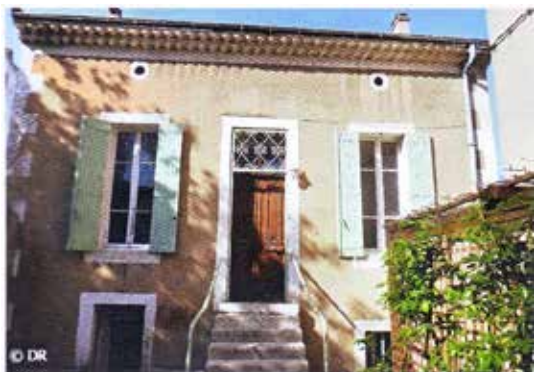
L'immeuble en l'état actuel...
